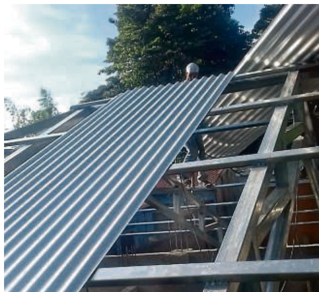
Die neue Dachkonstruktion aus Stahl.
