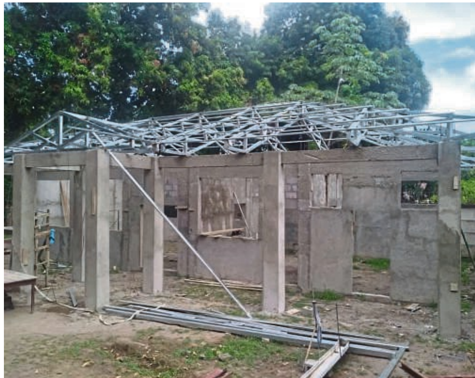
Das neue Waisenhaus entsteht. Gut zu erkennen ist das Zusammenspiel von Wänden und Dachkonstruktion, die inzwischen Fortschritte gemacht hat (Foto unten). FOTOS: P
